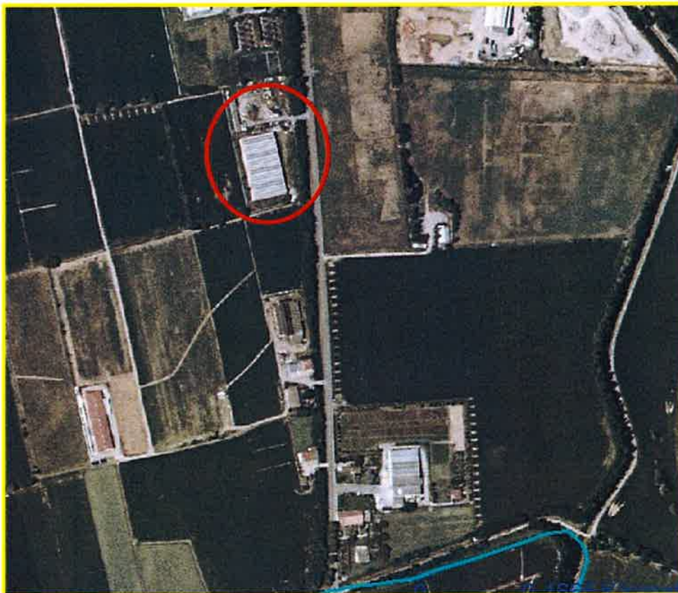
Figura 3.1.3. - Orto foto digitali – Compagnia generale riprese aeree – localizzazione impianto
